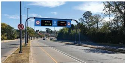
Avenida Colombres. Uno de los cinco corredores donde estarán las enormes estructuras.
